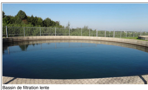
Bassin de filtration lente
